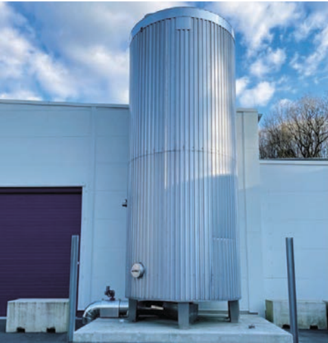
Beispiel aus der Praxis: 40.000 Liter Misch- und Ausgleichsbehälter (MAB) eines Mineralbrunnens für Abwasser
